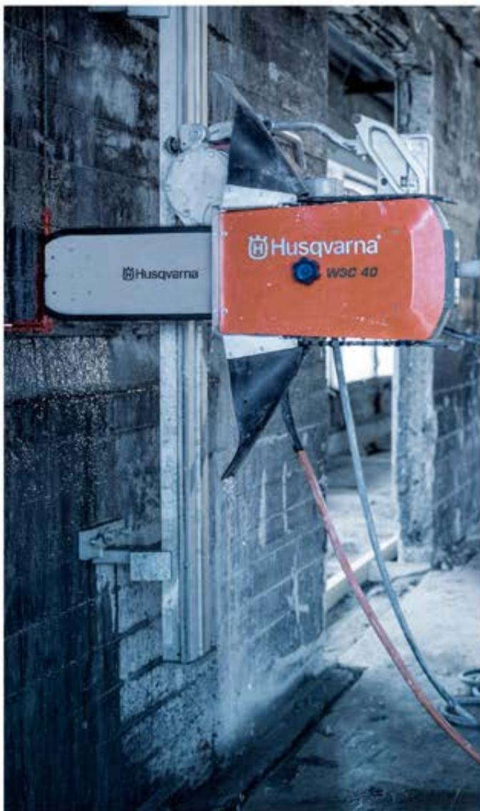
Husqvarna WSC 40 — подлинно уникальная насадка для тяжёлой работы, превращающая ваши дисковые стенорезные машины Husqvarna WS 482 HF и WS 440 HF в цепные. Обеспечивает эффективную и точную резку углов и небольших отверстий без перереза. Легко устанавливается на шпindel, входит в созданный диском пропил без изменения положения направляющей.
