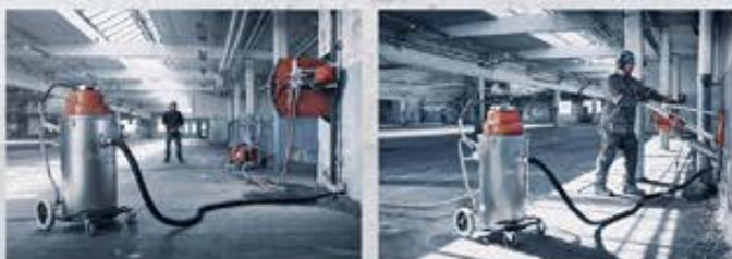
При влажной резке и бурении пыль связывается водой непосредственно у источника. Коллектор шлама, присоединенный к пылесосу с возможностью сбора шлама, поддерживает чистоту рабочего места.
